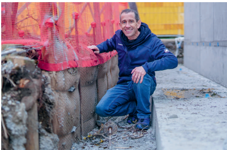
Fabian Dietrich zeigt, wie die Wurzeln eines Spitzahorns durch einen Wurzelvorhang geschützt werden, während daneben gebaut wird.
