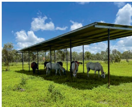
Le nouvel abri offre de l'ombre à nos protégés durant les mois chauds, et les protège des pluies.
