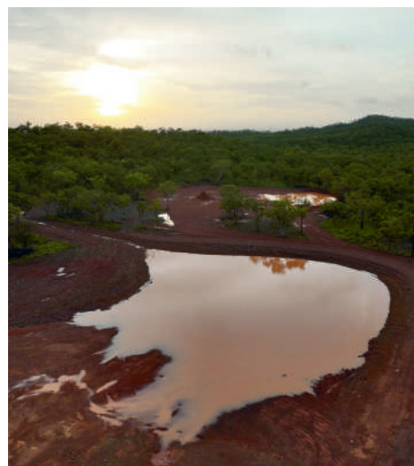
Une autre source d'eau importante à Bonrook : nos deux barrages récemment construits font 12 x 12 m et 30 x 30 m.
