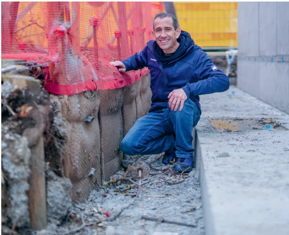
Fabian Dietrich montre comment les racines d'un érable plane sont protégées par un rideau pendant les travaux de construction.
