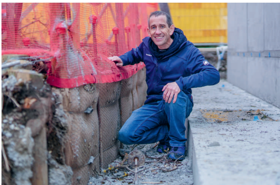
Fabian Dietrich zeigt, wie die Wurzeln eines Spitzahorns durch einen Wurzelvorhang geschützt werden, während daneben gebaut wird.
