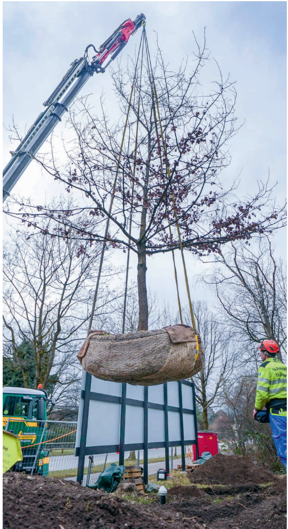
Die Stieleiche wurde mit einem leistungsstarken Kranwagen verpflanzt.
