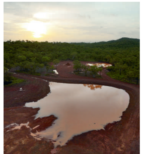
Une autre source d'eau importante à Bonrook : nos deux barrages récemment construits font 12 x 12 m et 30 x 30 m.
